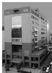
写真3 岩手医科大学循環器医療センター
