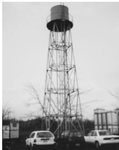
写真2 鉄塔上の高置水槽
