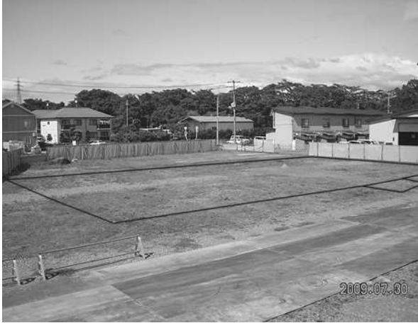
写真2 工事事務所から見た建設用地と建設予定場所
