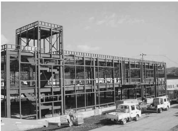
鉄骨がほぼ完成した新・医薬品衛生検査センター
