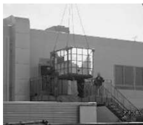
写真13： 2階への什器搬入
