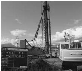
写真4：杭打ち工事
