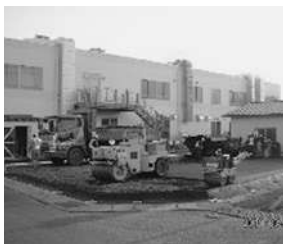
写真16： 外構舗装が始まった北側
