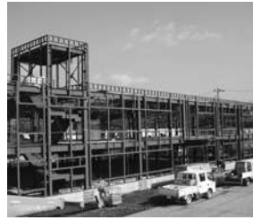
写真6： 鉄骨組立工事ほぼ完成
