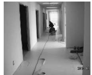
写真11： 2階廊下床張り工事
