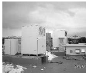
写真10： スクラバー・外気調節機(屋上)
