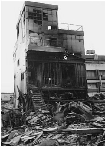
<震災後店舗写真>
