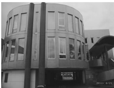
写真1. 大分県薬剤師会館
