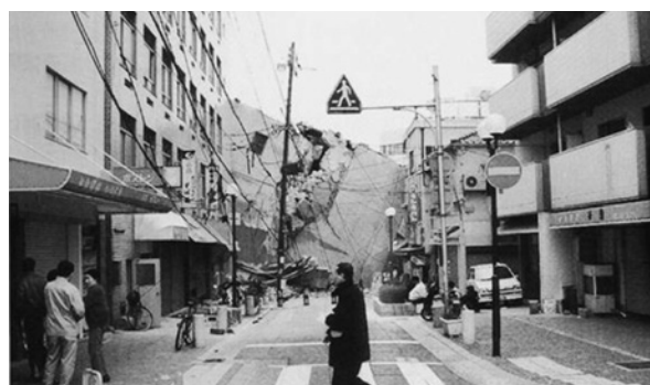
（写真中央：倒壊した兵庫県薬剤師会館）
