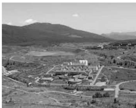
写真：北上川中和処理施設（八幡平市）
