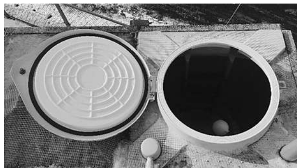
写真：外観検査（マンホール）
