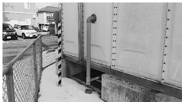
写真：外観検査（オーバーフロー管）
