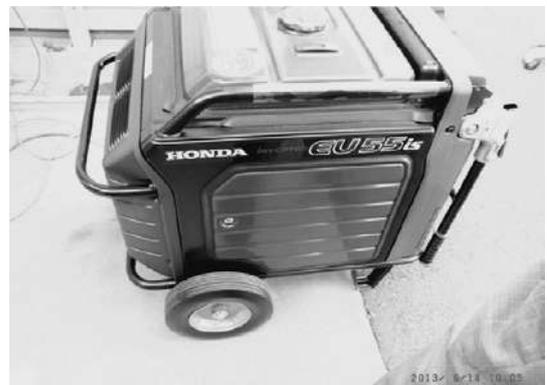
写真5. 恒温槽用非常電源発電機
